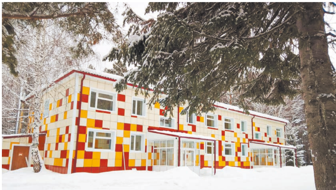
Так выглядит один из отремонтированных спальных корпусов лагеря
