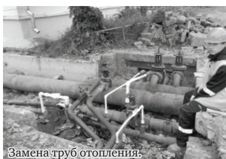
Замена труб отопления.
