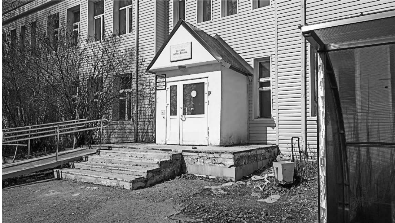
Здание детской поликлиники давно нуждалось в капремонте
