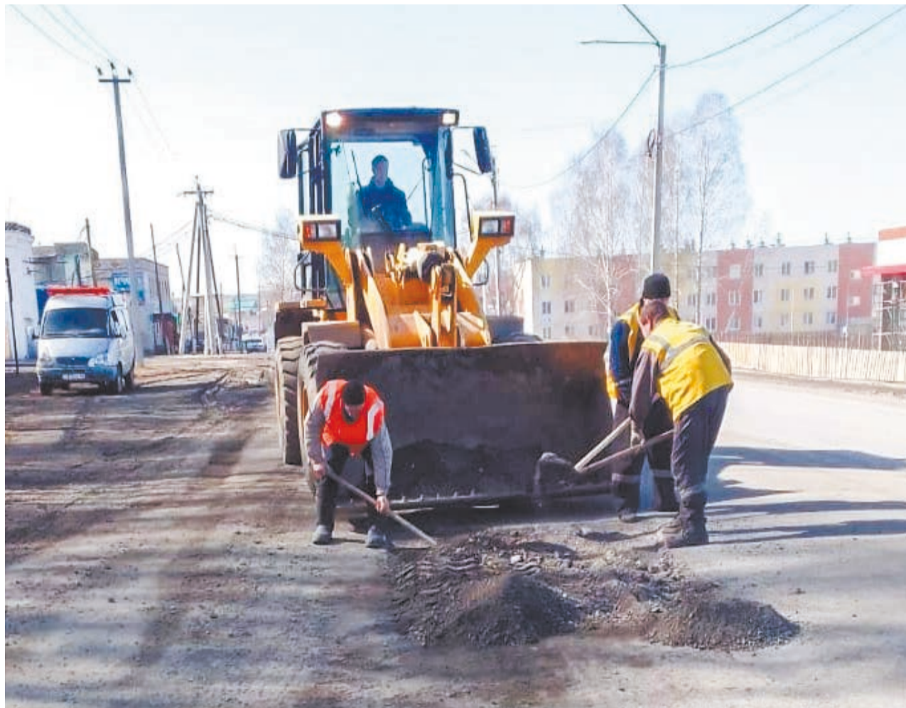
Дороги ремонтируют, в первую очередь, по маршрутам общественного транспорта
