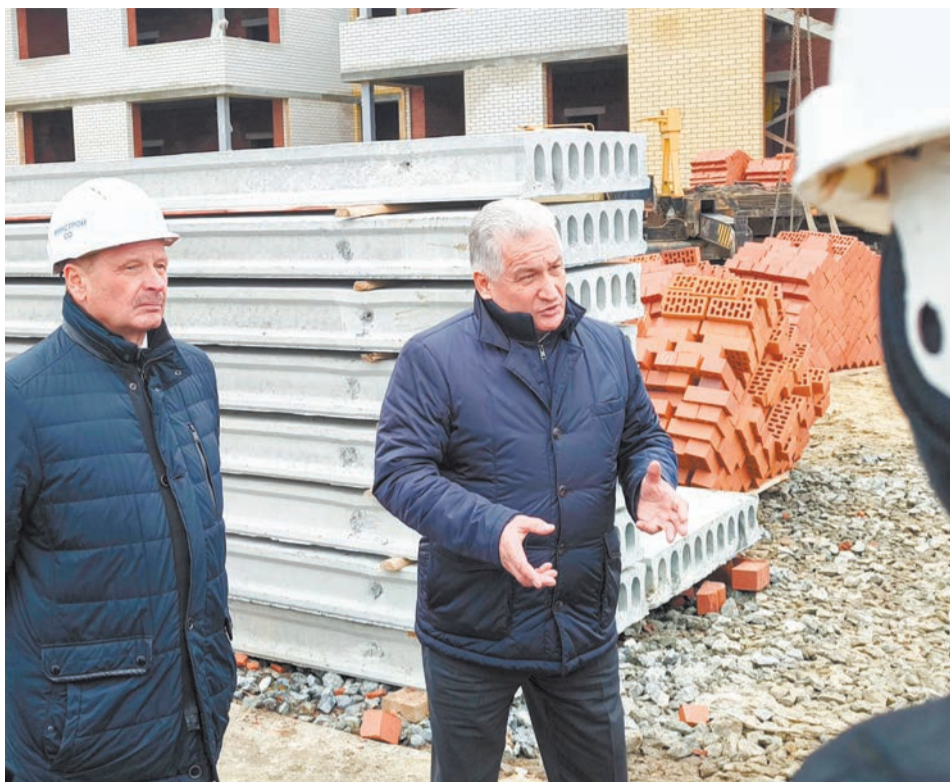
Юрий Биктуганов (в центре) на стройплощадке детского сада
