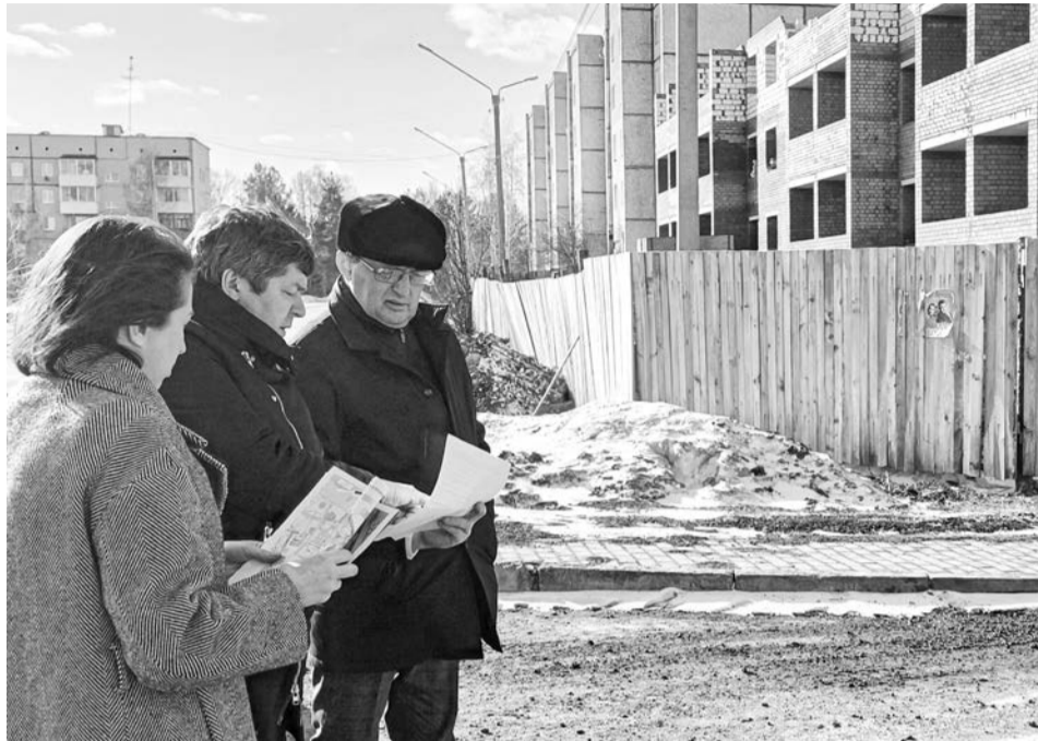
На стройплощадке многоквартирного дома
